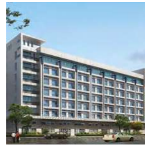
Niższe budynki wielkopowierzchniowe
